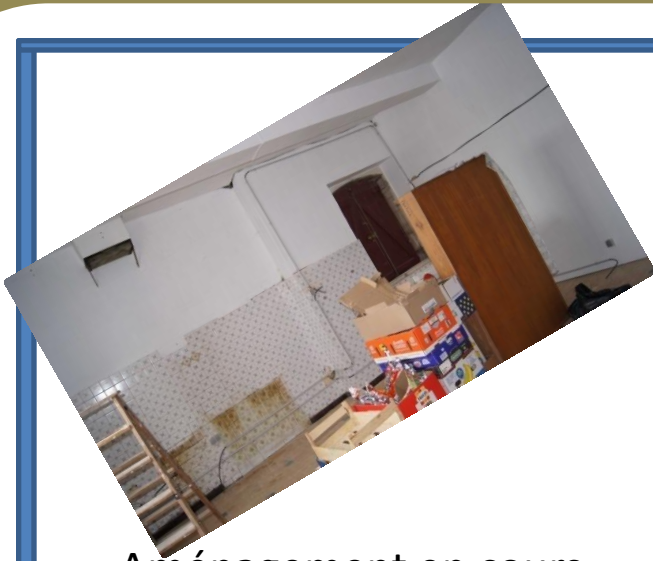
Aménagement en cours Extension de la distribution
